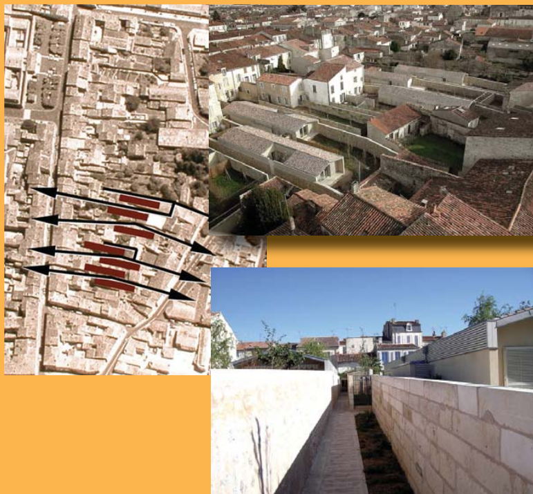
Exemple de densification d'un îlot à Saintes, en respectant les formes laniérées du tissu urbain
