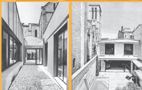
Reconversion d'atelier Bordeaux, Frederik Dain, arch.
